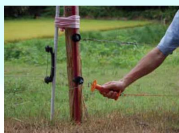
侵入防止柵の設置
