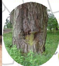
福島県矢吹町大池公園
